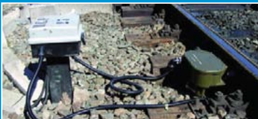
La protección de cables de poliamida de PMA se utiliza en la infraestructura ferroviaria para la protección contra piedras y grava.
