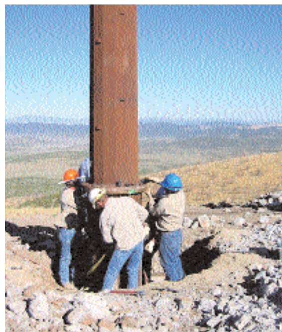
Instalación de las bases en el proyecto Falcon-Gondor
