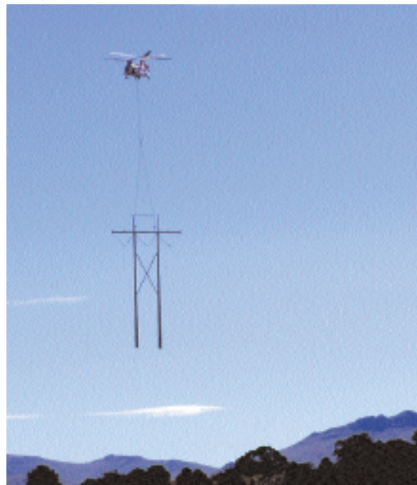
Los postes Meyer son instalados con helicópteros en Nevada.
