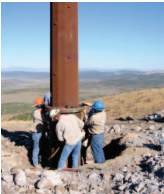
Installation de la fondation pour Falcon-Gondor
